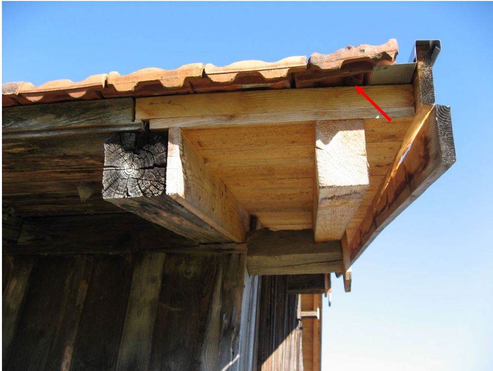
Abbildung 12: Einschupfmöglichkeit für Fledermäuse in das Zwischendach der Scheune (roter Pfeil).
