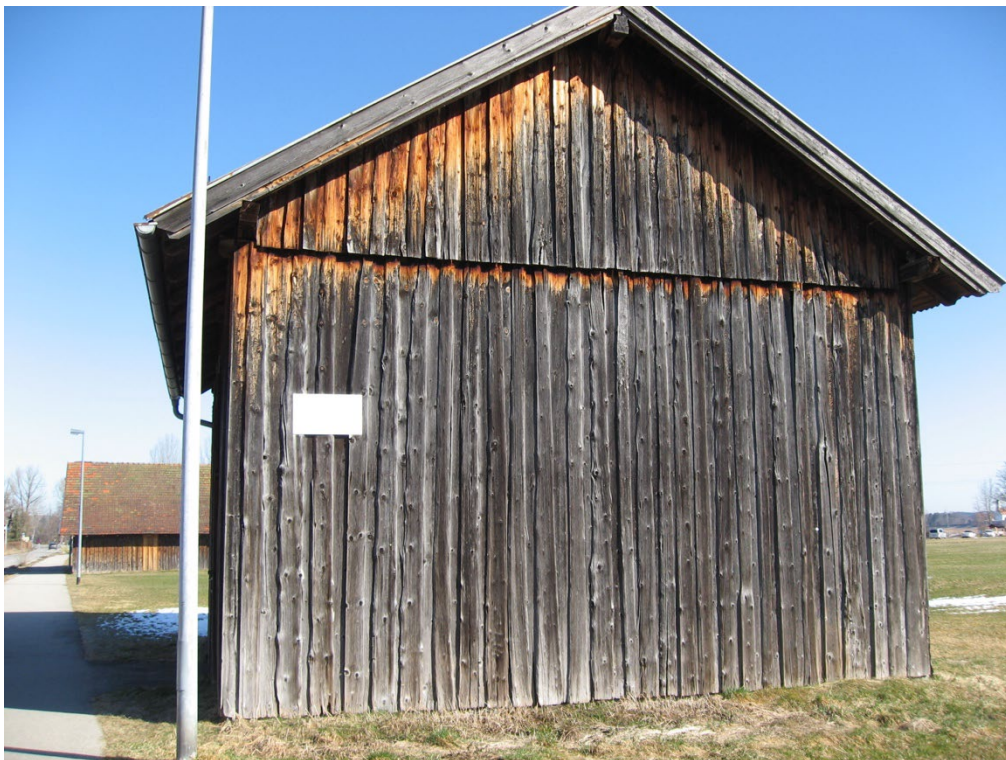
Abbildung 11: Am Westrand des Plangebietes gelegene Scheunen, Blick von Süden.
