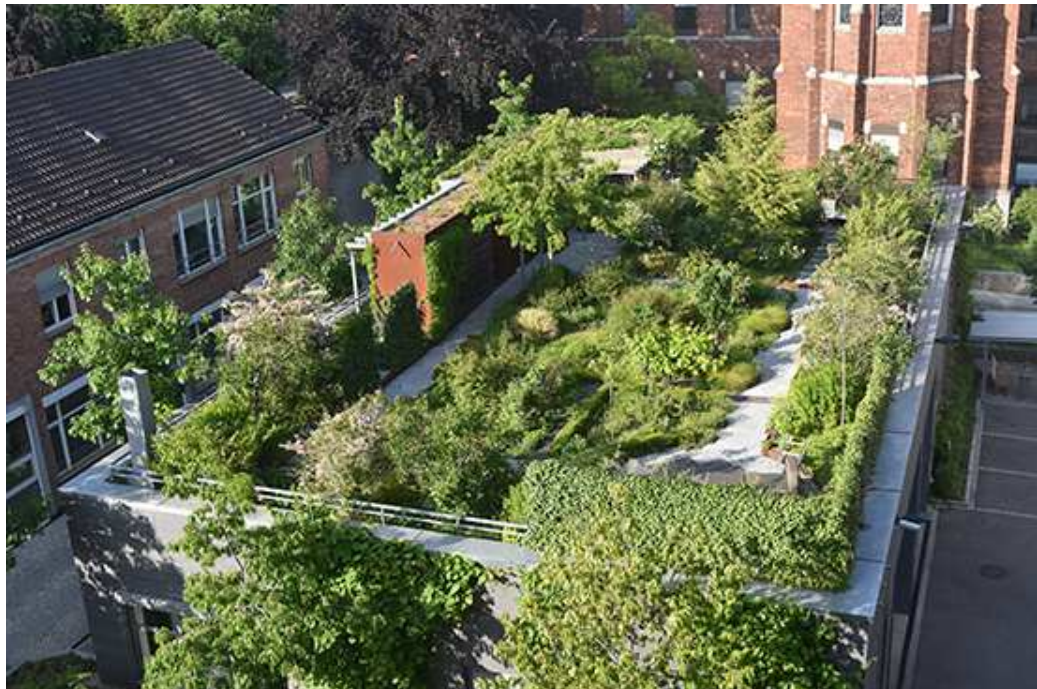
© Laura Hörner; Beispiel für ein als Dachgarten ausgebildetes Gründach auf dem Wirtschaftsgebäude der Diakonissen Klinik Augsburg
