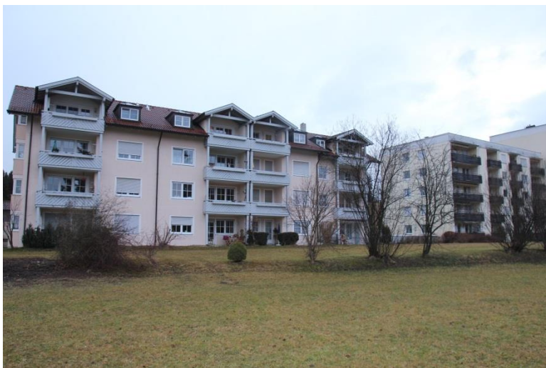
Blick auf das Plangebiet nach Norden
