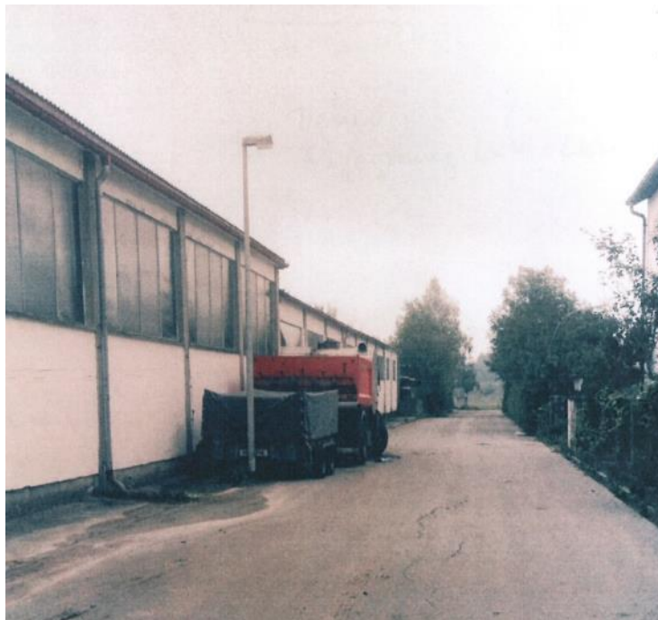
Abbildung 6: beengter Straßenraum in der „Straße“ Am Kühbrunnen
