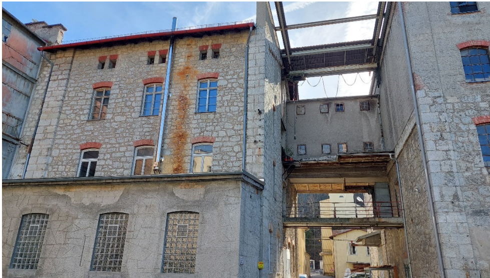
Abb. 17: Gebäude mit Vogelnestern und Quartier- potenzial für Fledermäuse.
