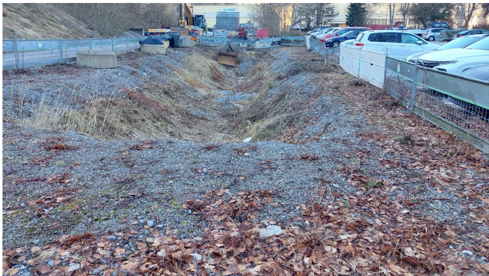
Abb. 14: Reste des vormaligen-Mühlenbachs.
