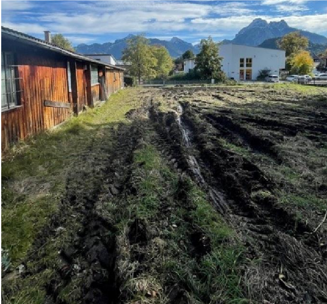
Ehemalige Grünlandbrache im südlichen Vorhabensgebiet, bei den Rodungsarbeiten zerfahren, Blick nach Osten.
