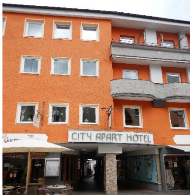
Abbildung 78: City Apart Hotel in der Altstadt Quelle: cima 2020
