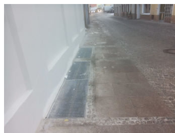
Abb. 2 Belüftungsschacht mit Abdeckungen
