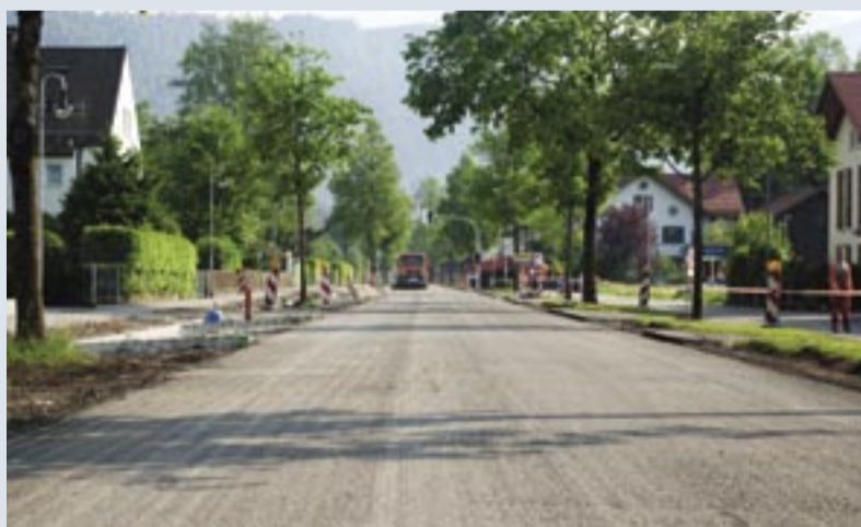
Die Augsburger Straße während der Bauarbeiten
